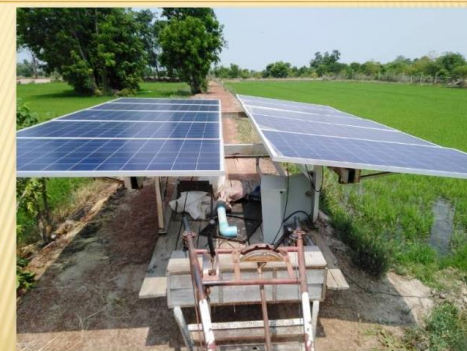
4.2 ใช้พลังงานแสงอาทิตย์สูบน้ำเข้าแปลงเมล็ดพันธุ์
